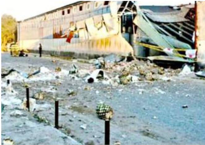
■ El estallido ocurrió en una caldera y se propagó hacia tres contenedores llenos con 219 mil litros de tequila.
