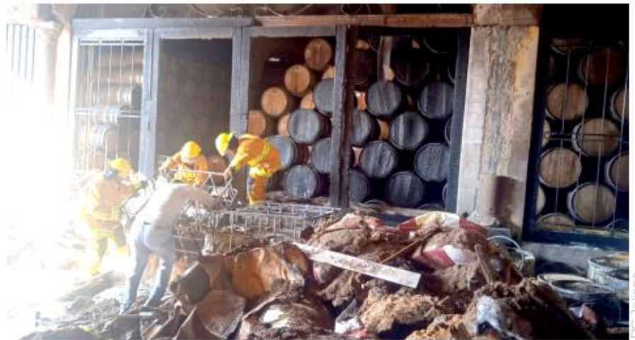
De manera preliminar, el mandatario dijo que se hacían trabajos de soldadura.
