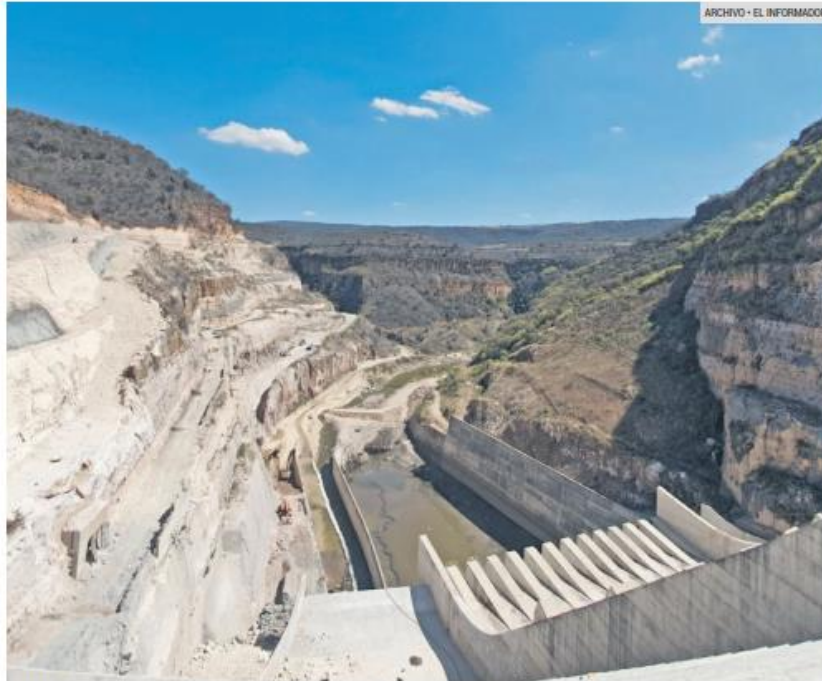
AGUA. La infraestructura está casi lista. Dotará de agua a la Zona Metropolitana de Guadalajara.
