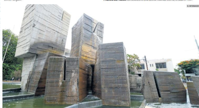
FUENTE DE LA HERMANA AGUA. Creada en 1970, esta obra es un ejemplo del estilo arquitectónico conocido como Brutalismo.
