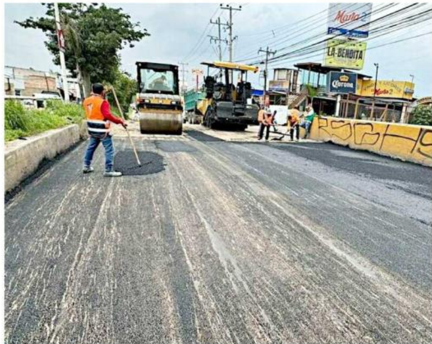
Trabajan tres cuadrillas en las labores de bacheo.
