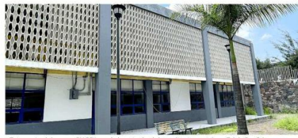
Esta parte del nuevo CUGDL, es de la autoría del arquitecto austriaco Erich Coufal.
