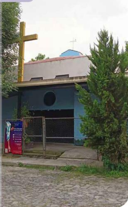
En análisis demolición de Capilla en Arroyo Seco
