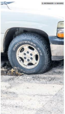
IMÁGENES QUE DUELEN. Los conductores señalan que no siempre es posible esquivar todos los hoyos en el camino, lo que lleva a dolorosos encuentros.
