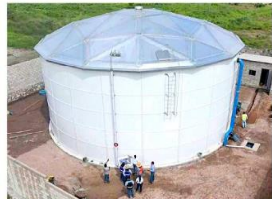
■ Macrotanque que se construye en el Cerro del Gato.
