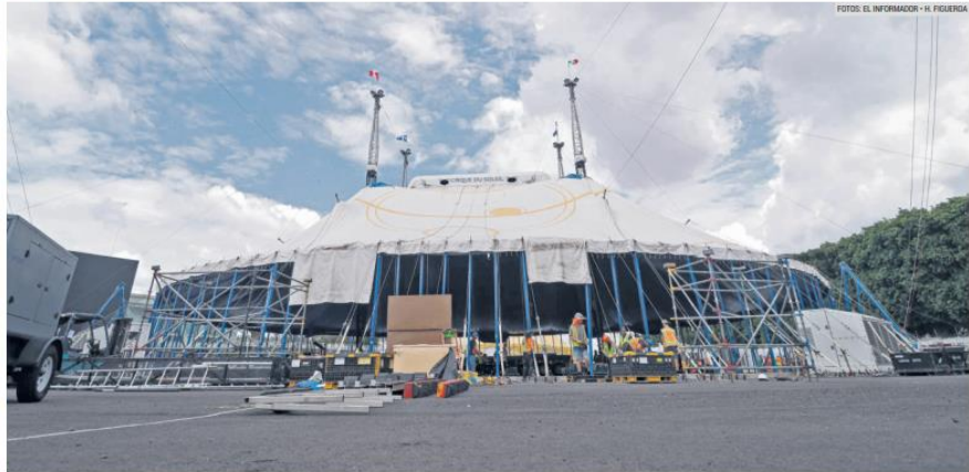
CARPA. Las instalaciones que albergarán al espectáculo "Kurios" comienzan a tomar forma.
