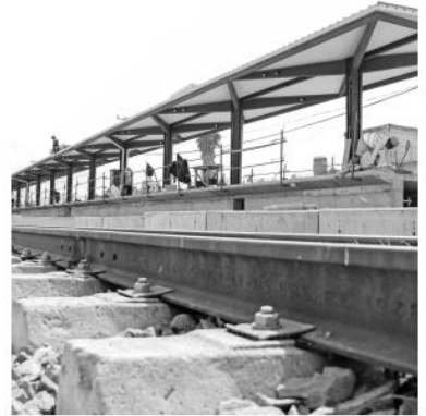
Avance importante en estación Tlajomulco Centro.
