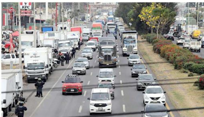
■ Aumentarán carriles y renovarán el pavimento. El transporte correrá por en medio de la vía.
