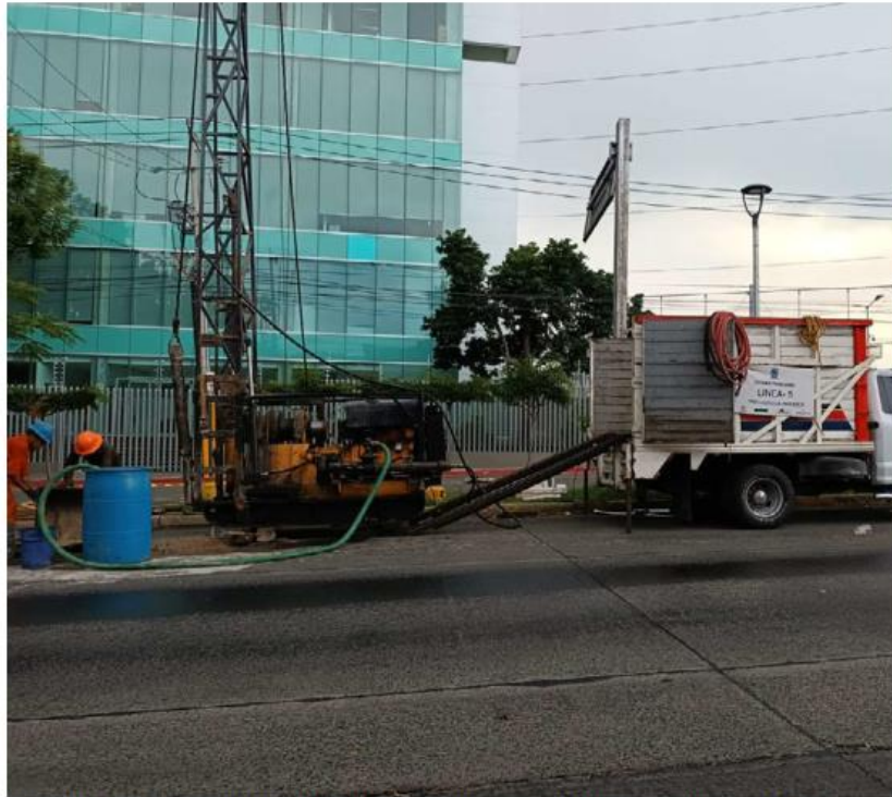
Esta misma semana comenzaron los estudios de mecánica de suelos para la obra. M. BAEZA
