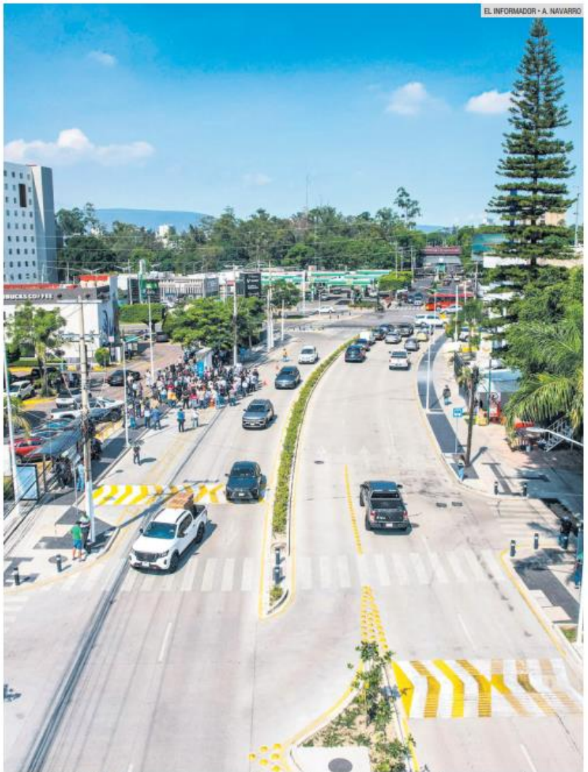
ADIÓS A LOS BACHES. Durante años, automovilistas sufrieron el deterioro de esta importante avenida.
