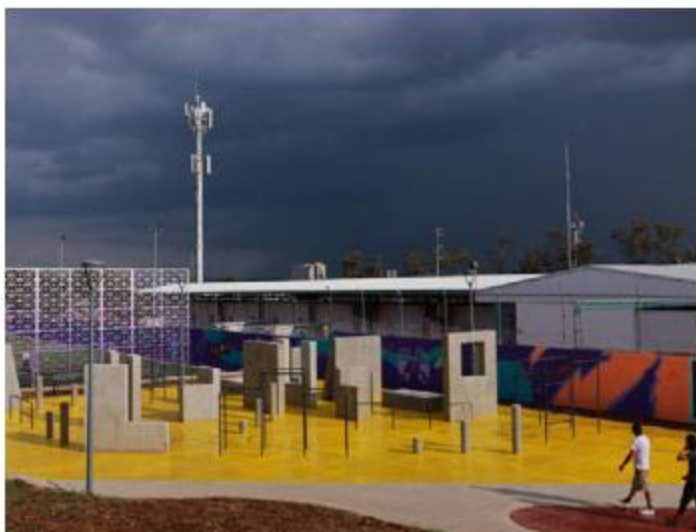
OBRAS. El gobierno de Zapopan inauguró la Unidad Deportiva El Frijol, la cual cuenta con canchas de uso múltiples y espacios para picnic. La obra tuvo una inversión de 15 millones de pesos.
