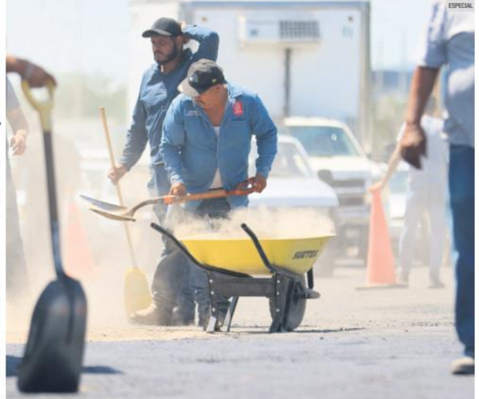
OPERATIVO DE BACHEO. Ayer se rehabilitaron 400 metros del Camino Real a Colima.
