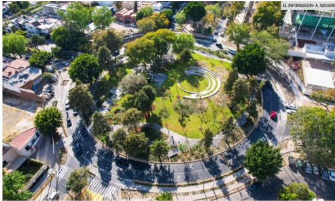
CIUDAD. Toma aérea que muestra cómo quedó la rehabilitación de la Glorieta Monraz.
