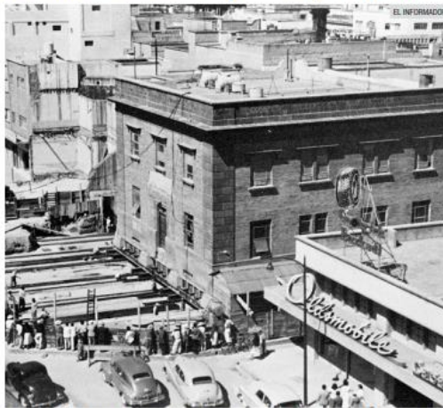
INGENIERÍA. En la foto se muestran los 12 gatos hidráulicos que empujaron el edificio de la compañía telefónica, perfectamente sincronizados.
