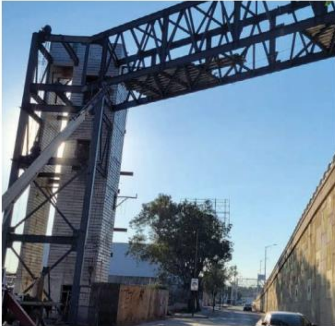
La construcción de las torres de elevadores de la estación "Las Juntas" registra un avance considerable. ESPECIAL
