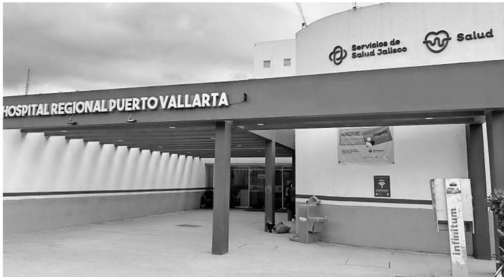
La rehabilitación y ampliación de infraestructura hospitalaria. /CORTESÍA SALUD JALISCO
