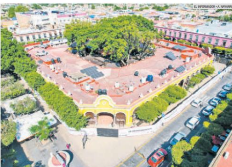
REHABILITACIÓN. El emblemático destino cultural y gastronómico de Tlaquepaque está cerca de reabrir sus puertas, luego de las obras que se están haciendo al interior y exterior del edificio.
