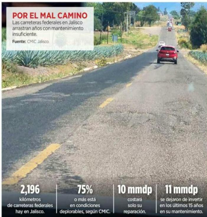
La carpeta asfáltica de la carretera federal 90, que conecta a Zapotlanejo con Degollado, Jalisco, es una de las vías en mal estado.
