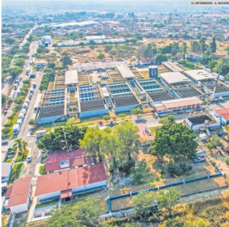
PLANTA DE TRATAMIENTO DE SAN GASPAR. El corte en el suministro se debe a la interconexión del sistema de El Zapotillo con esta infraestructura, buscando incorporar una nueva fuente de agua para la metrópoli.
