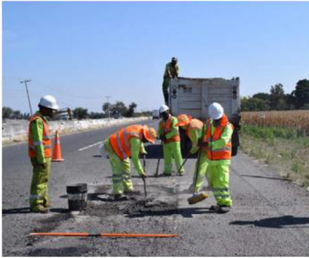
Se realizarán trabajos de bacheo y otras mejoras. ESPECIAL
