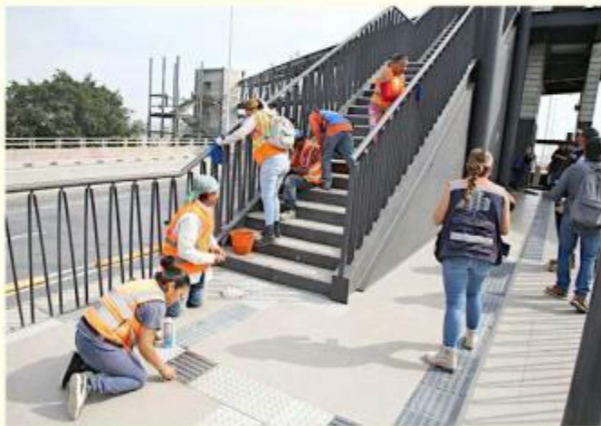
■ Ayer se estaban dando los últimos detalles de los trabajos.
