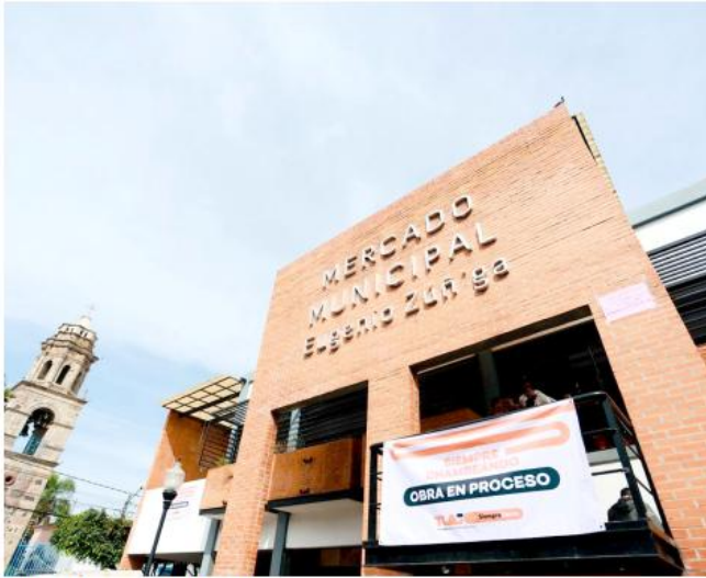
En la obra se invertirán 12 millones de pesos.
