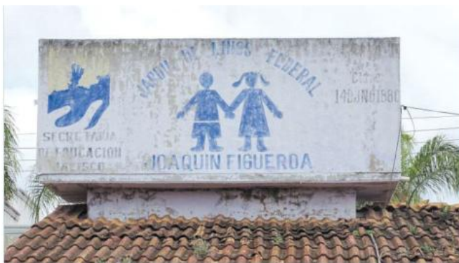
Así lucía antes de la reconstrucción.
