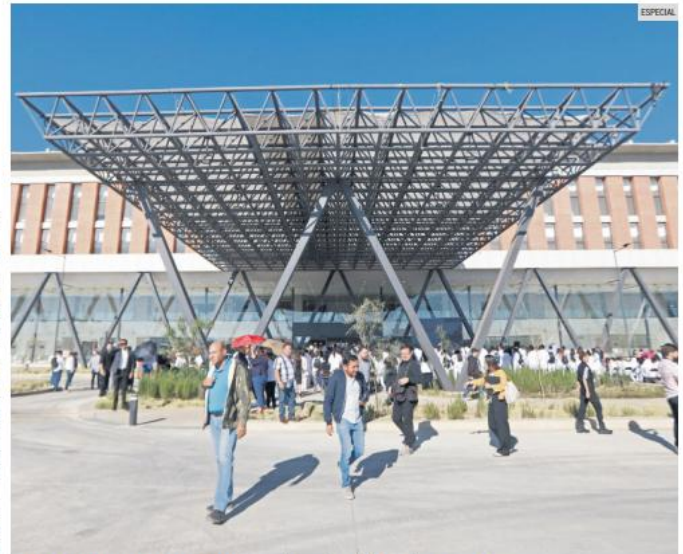
ABRE SUS PUERTAS EL EDIFICIO A. Parte del Hospital Civil de Oriente, en Tonalá.
