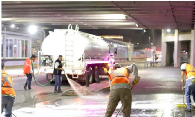
Realizaron trabajos de hidrolavado de las banquetas con agua, jabón y cloro.
