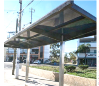
Fueron analizados los puntos que requerían intervención prioritaria.
