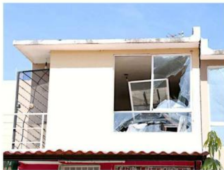
La tarde de ayer todavía continuaban los trabajos.
