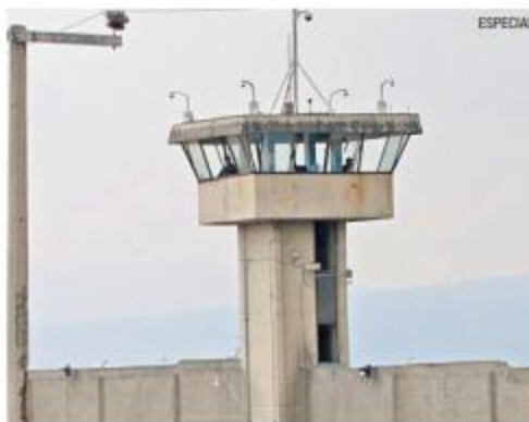
PUENTE GRANDE. Registró una nueva evasión en sus instalaciones en diciembre pasado.
