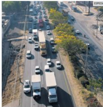
CARRETERA A CHAPALA. Es considerada una de las vías de más difícil tránsito debido al descuido en su mantenimiento.
