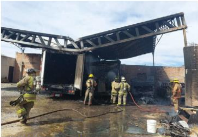
SINIESTRO. En Lagos de Moreno, una bodega terminó en pérdida total tras un incendio. El hecho ocurrió en la colonia Los Jacales.
