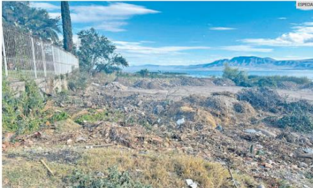
DELITO AMBIENTAL. Mientras el Ayuntamiento de Jocotepec afirma que se realiza una obra pública, las autoridades federales confirman que esto es ilegal, pues no hay un solo permiso autorizado.
