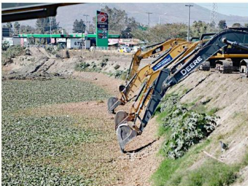
Se destinarán 15 millones de pesos en los trabajos de prevención.
