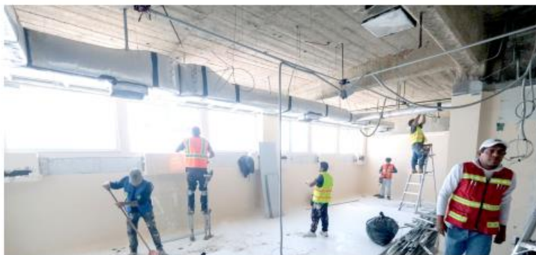
Ya se está trabajando en las adecuaciones.
