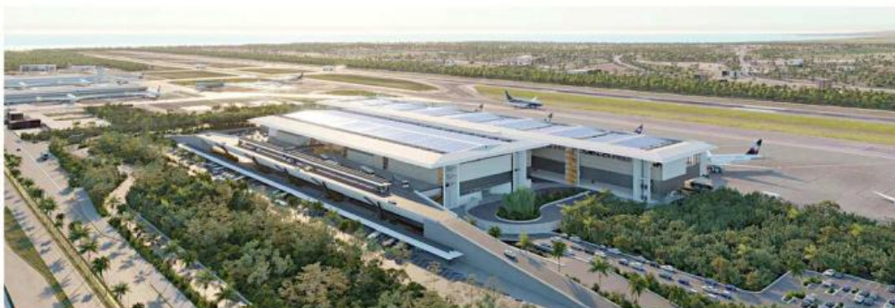
De acuerdo con el GAP, así se vería el Aeropuerto Internacional de Puerto Vallarta cuando termine la construcción de la T2.
