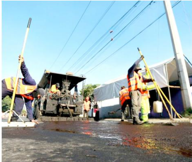
El alcalde Gerardo Quirino dio el banderazo para el inicio de los trabajos.
