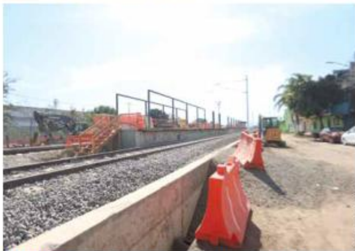
AÚN EN OBRAS. Actualmente se construye una nueva estación de la L4 en Tlaquepaque. Fue solicitada por la presidenta Claudia Sheinbaum.
