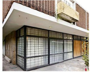
La Casa Ortiz Parra, diseñada por Enrique Nafarrete en 1958 y ubicada en la Colonia Vallarta Poniente, fue demolida en 2023.
