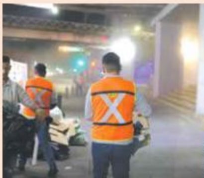
TRAMO. La intervención se realizó entre las calles Antonio Castro y Agua Dulce.
