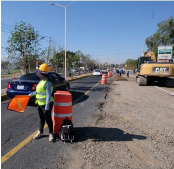
De manera inicial, los trabajos de apoyo en ambas vías estarán a cargo de las empresas constructoras. ESPECIAL
