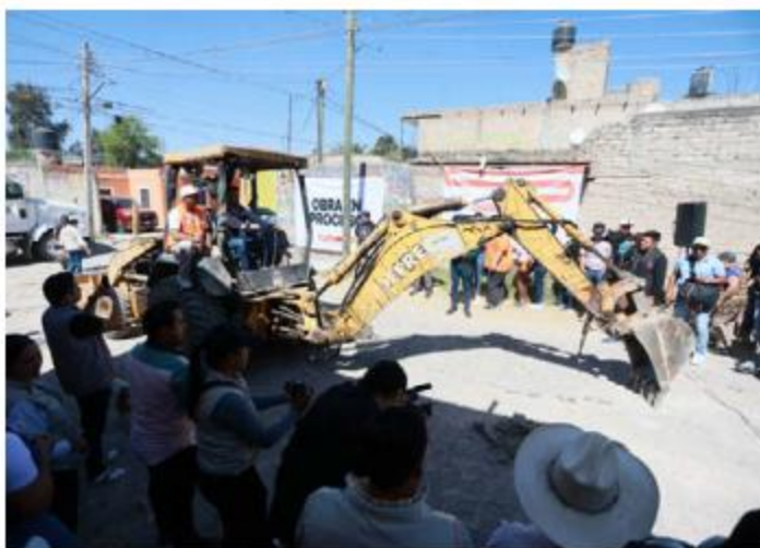
INFRAESTRUCTURA. Tlajomulco realiza intervención integral en vialidades y drenaje de la zona Valle; la inversión asciende a los 13 millones de pesos.
