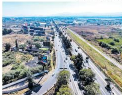
En remodelación la vía hacia el aeropuerto.
