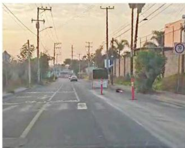
■ Carril cerrado por obras de un colector de drenaje sobre Bulevar Bosques de Santa Anita.
