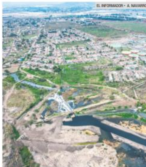
INVASIONES. Las construcciones y los tiraderos ilegales en la zona de la presa representan un riesgo.
