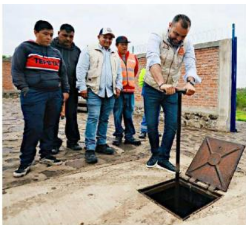
■ Ayer se puso en marcha la obra de interconexión con la planta potabilizadora, para llevar agua potable al Fraccionamiento Arvento.
