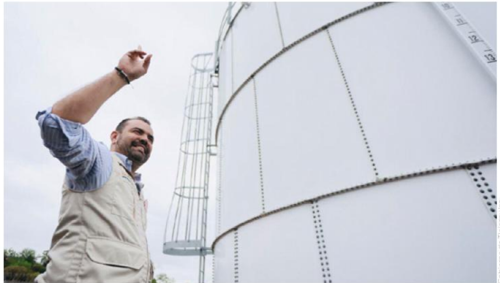
La obra contempla la conexión directa con la Planta Potabilizadora número 5.
