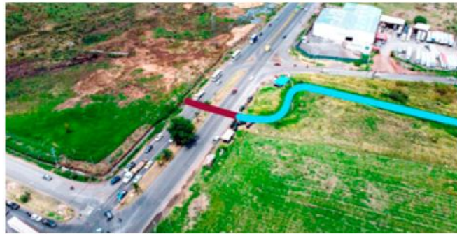
La presidenta municipal, Nena Fariás, dio la instrucción de que se coloque una tubería y un colector.
