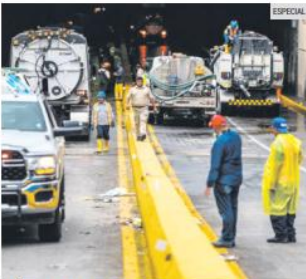
LÓPEZ MATEOS. Bomberos y personal de Protección Civil trabajaron durante horas para desalojar el agua acumulada en túneles.
