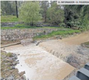
RIESGO. El Canal de Patria provocó encharcamientos a la altura de Los Colomos.
