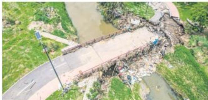
**COLAPSO.** Un puente peatonal construido en el parque quedó inservible tras el paso de una lluvia, que las autoridades calificaron de "atípica" para la zona.
