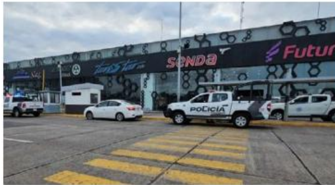
El horror terminó en el Módulo 7 de la Central Nueva. ESPECIAL
