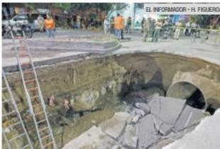
**CAUSA.** Según el SIAPA, el colapso fue provocado por fallas en un colector pluvial de la zona.
