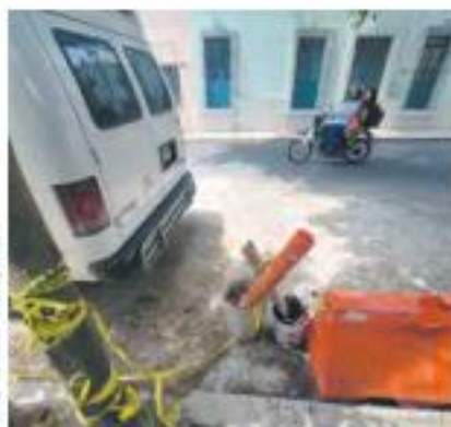
TIENEN POCO. Las obras de reparación en el socavón terminaron apenas el miércoles pasado.
