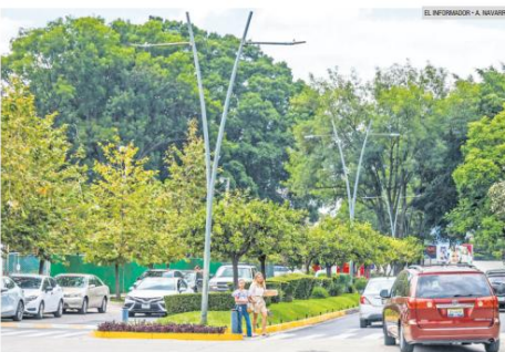
COLONIA MONRAZ. La Diagonal Golfo de Cortés luce sin cableado entre los postes, mejorando la imagen urbana y evitando accidentes. Sin contar los Centros Históricos, es una de las pocas calles con redes subterráneas en la metrópoli.
