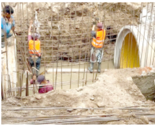
La reparación busca restablecer el sistema de drenaje pluvial.
