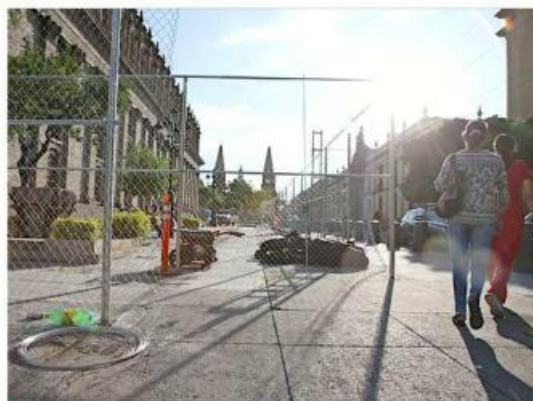
■ Ayer se empezó a colocar malla ciclónica alrededor del Teatro Degollado. Se restringirá el paso a la zona de obras.
