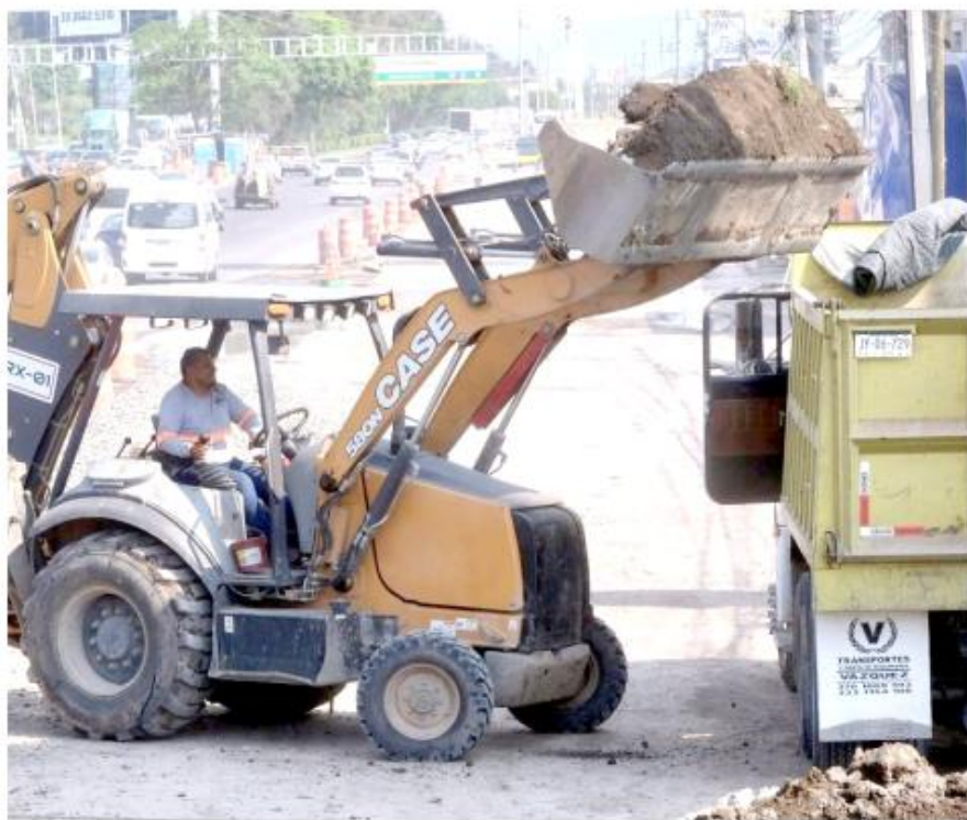
En la siguiente etapa, se intervendrán dos carriles centrales.
