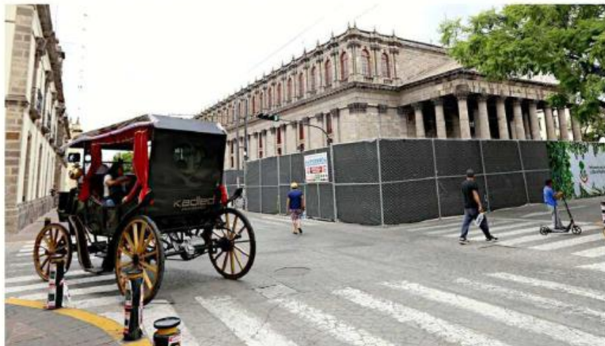
■ Las lonas y mallas colocadas en torno a las obras impiden ver algunos sitios del Centro Histórico de Guadalajara.
