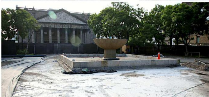
La Plaza Liberación está en proceso de restauración dentro del paquete de obras de los Perímetros A y B.
