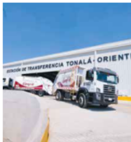
INICIALMENTE. La estación Tonalá-Oriente tendrá la capacidad de transferir mil 500 toneladas de residuos al día.
