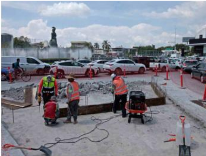
LABOR. Se pusieron en marcha las obras de remodelación de la Glorieta Minerva con motivo del Mundial de Fútbol de 2026. El monumento fue parcialmente cercado con malla ciclónica.
