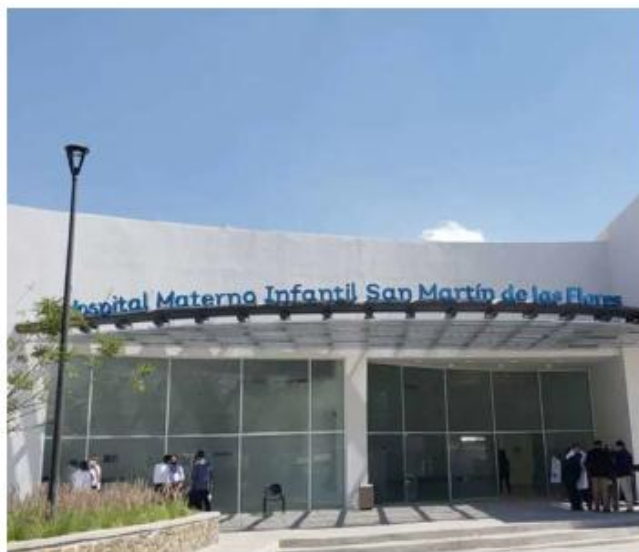
Las afectaciones fueron por filtraciones de agua. DIANA BARAJAS
