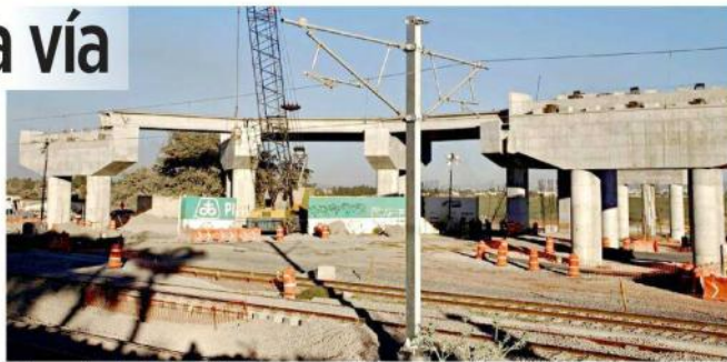
El paso elevado de la Estación El Cuervo conectará con diversos fraccionamientos de Tlajomulco.
