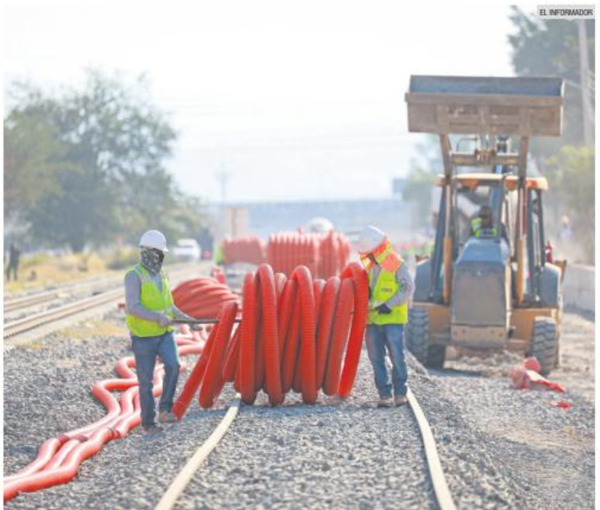
OBRAS. Avances de la construcción de la Línea 4 del Tren Ligero, que conectará Tlajomulco con Guadalajara.
