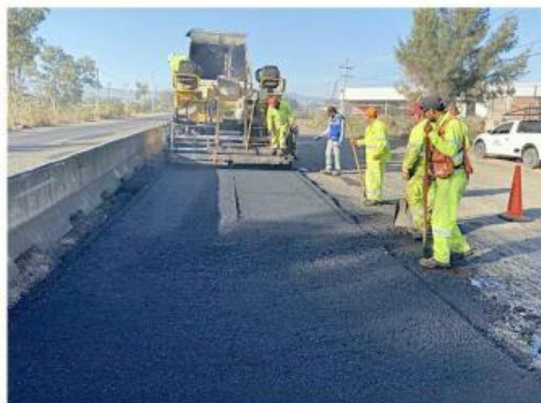
La de Autlán será la primera vía federal en ser intervenida este año en Jalisco.
