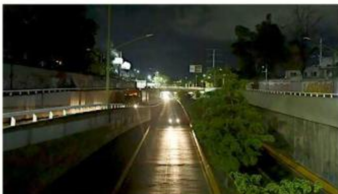
■ El robo de cableado afecta algunos servicios como el de alumbrado público.
